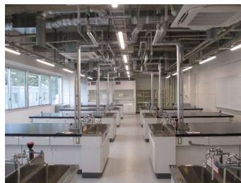
（改修後）化学棟 111実験室
